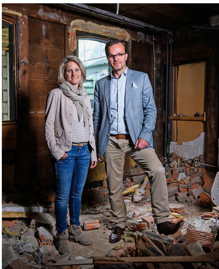
Gastgeber Chantal und Volker Beduhn auf der Baustelle im Hotel Bären. Hier entsteht die neue Küche. Foto: Raphael Moser
